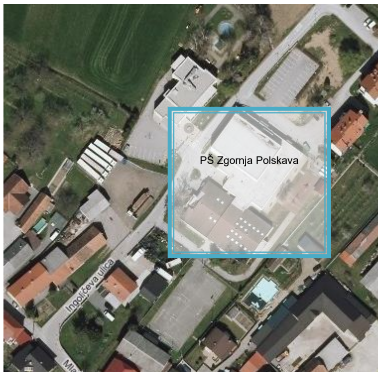
Slika 13.1: Potencialna SE na stavbi OŠ Antona Ingoliča PŠ Zgornja Polskava.
