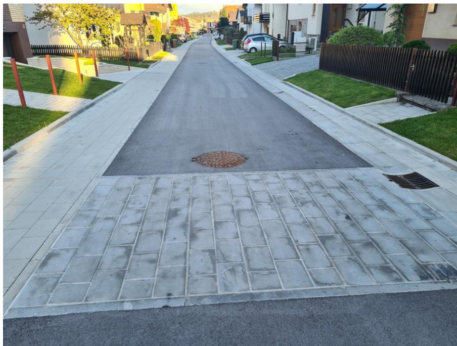
Slika 24: Podlaga iz asfalta in betonskih tlakovcev – Vrtna ulica v Ljutomeru
