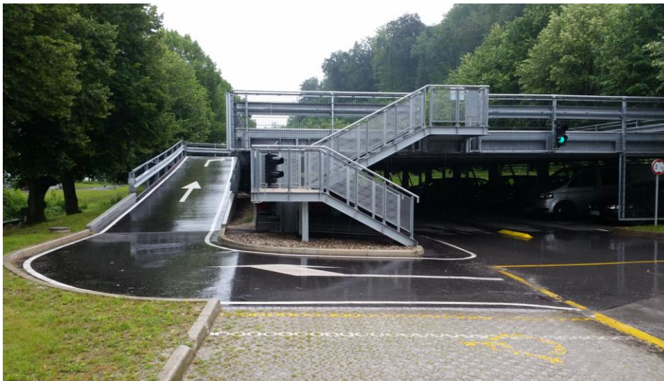
Slika 32: Primer nadgradnje montažne parkirne etaže v Rogaški Slatini
