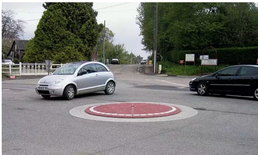
Slika 16: Primer montažnega mini krožnega križišča
