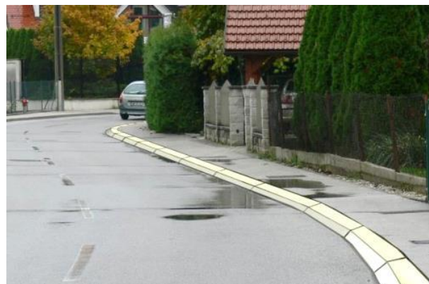
Slika 23: Obstoječi pešcem neprijazen (valovit) pločnik (levo) in predlog nižanih pločnikov s posnetim robnikom (desno)
