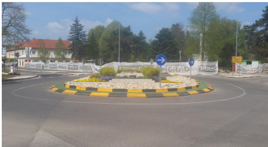
Slika 17: Primer urbanega montažnega krožnega križišča v Murski Soboti
