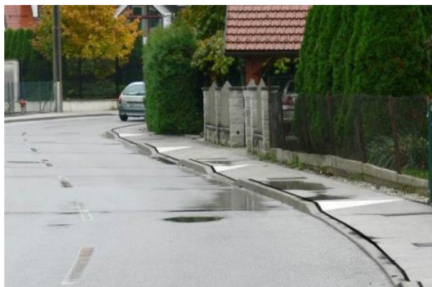
Slika 23: Obstoječi pešcem neprijazen (valovit) pločnik (levo) in predlog nižanih pločnikov s posnetim robnikom (desno)
