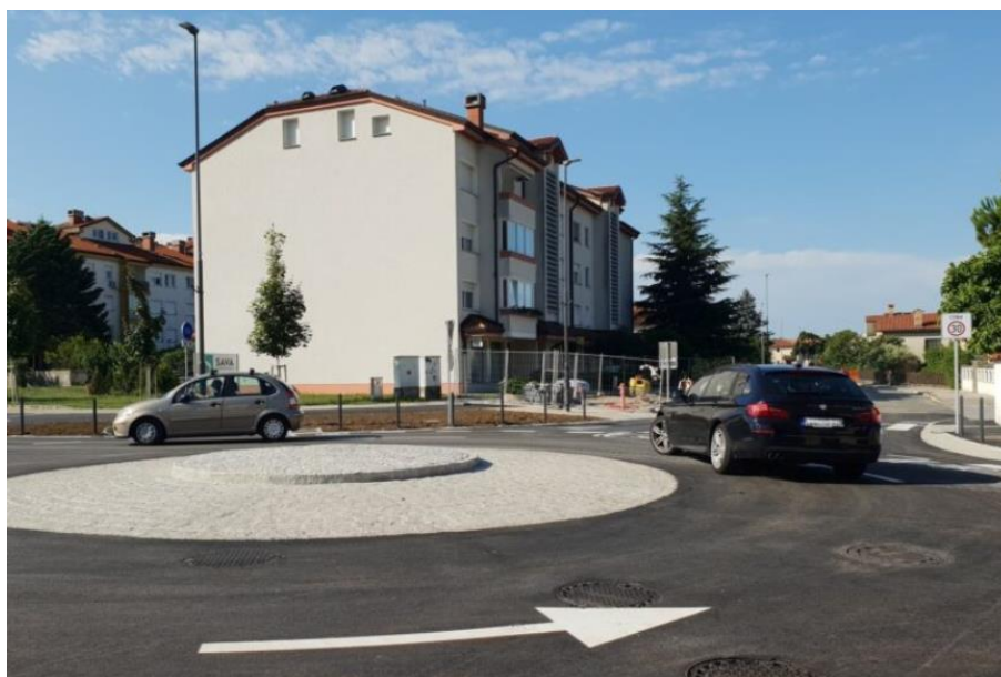
Slika 38: Primer mini krožnega križišča v Solkanu
