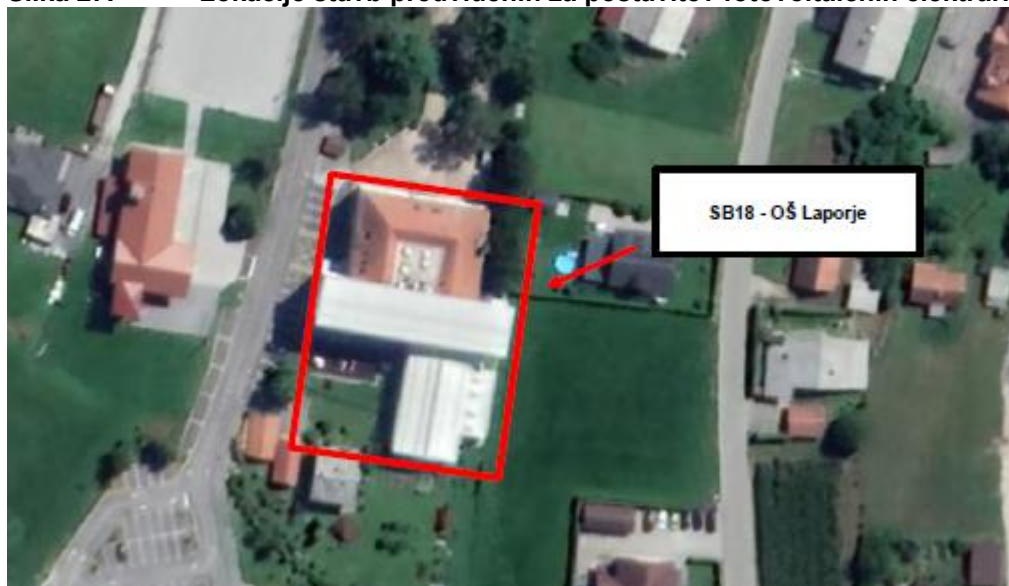
Slika 27: Lokacije stavb predvidenih za postavitve fotovoltaičnih elektrarn: OŠ Laporje
