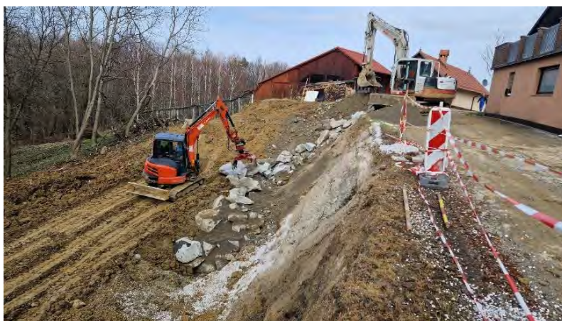
Sanacija plazu ob javni poti Vrhole pri Laporju
