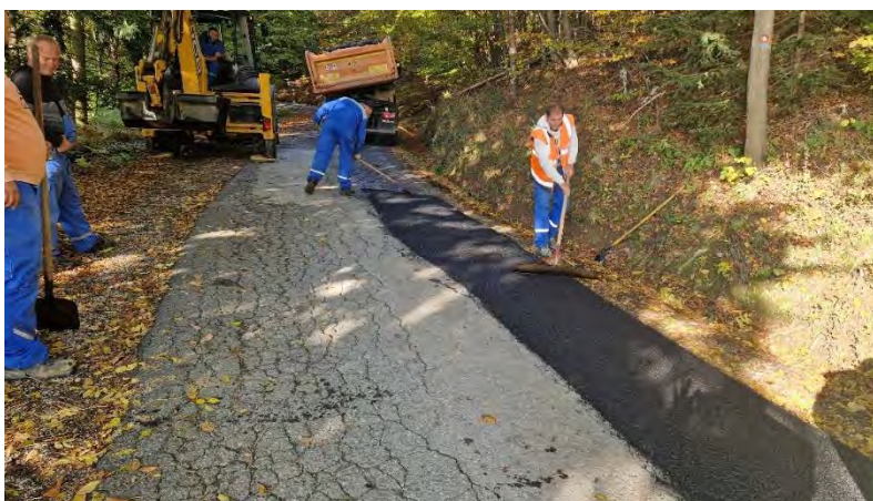
Krpanje udarnih jam na LC v Gaberniku
