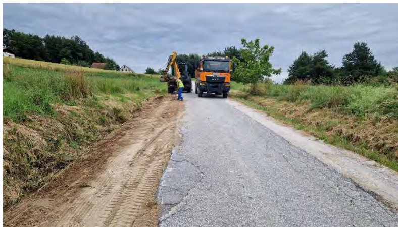
Redno vzdrževanje bankin in jarkov na lokalni cesti v Videžu
