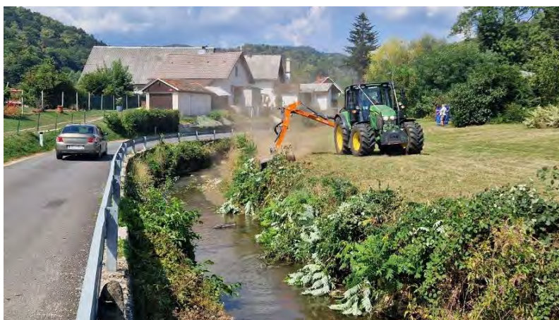
Mulčenje brežine potoka v Zg.Polskavi za zagotovitev preglednosti ceste
