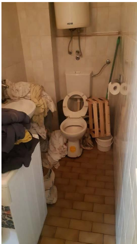
Primer obnove kopalnice pred izvedbo...
